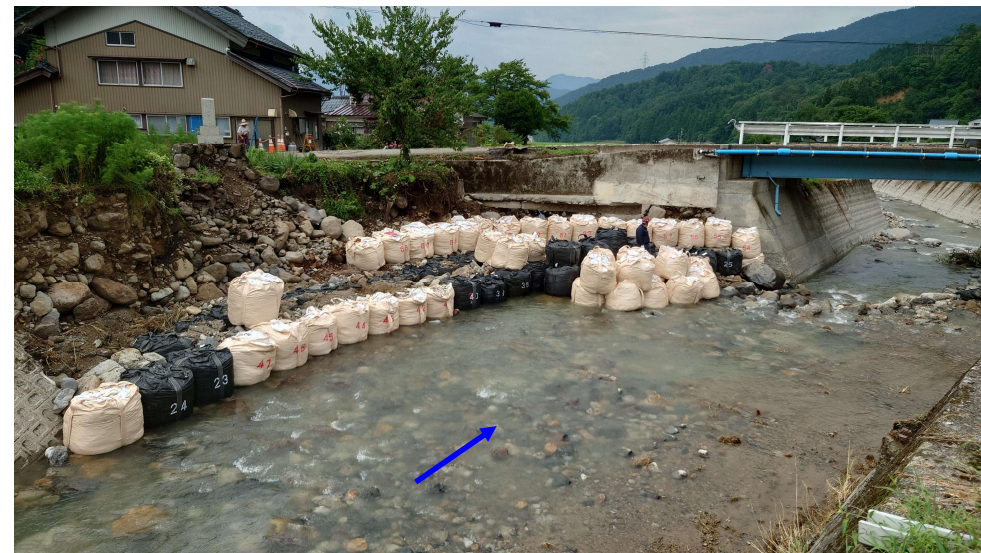
8/10 10:30大型土嚢設置作業状況
