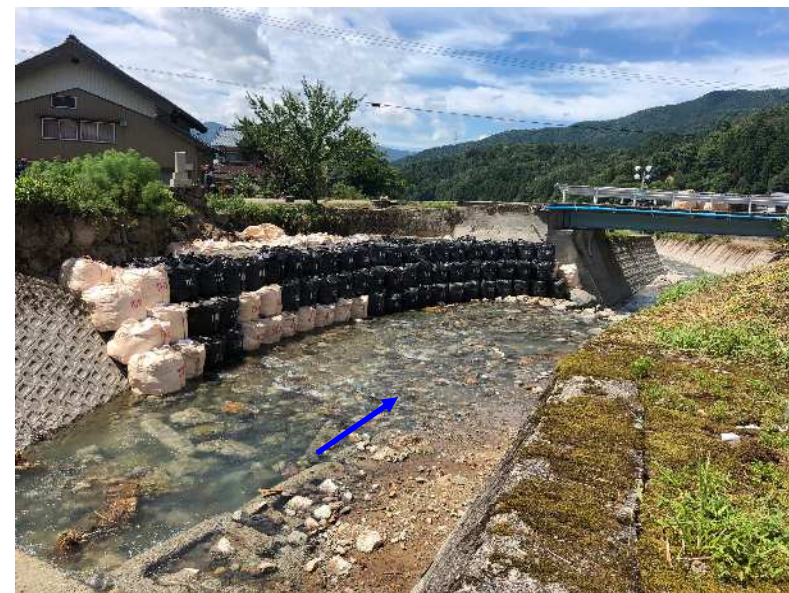
8/10 22:00大型土嚢設置完了(8/11 10:30撮影)
