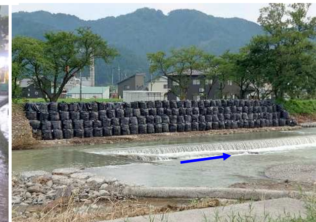
8/10 17:00 川表側土嚢設置完了
