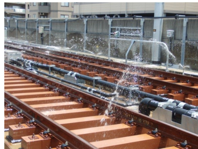
散水消雪装置(スプリンクラー)
