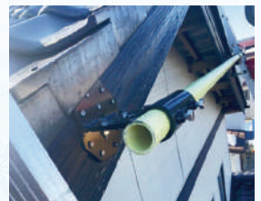
アンカー設置状況
