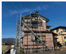
仮設足場の設置状況
