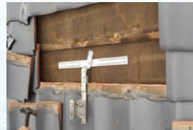
アンカーの設置状況
