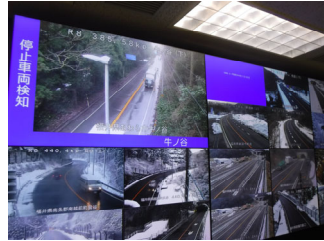
道路情報室モニターアラート状況
