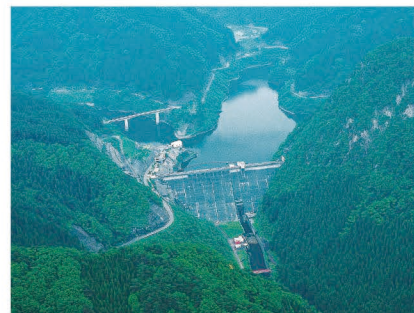
龍ヶ鼻ダム(県土木部管理)
