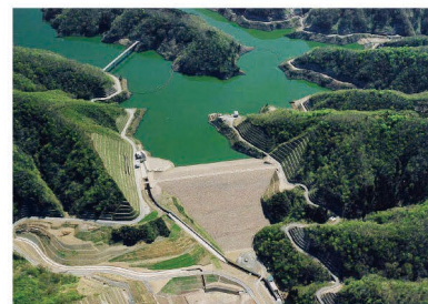
桧谷ダム (県土木部管理)
