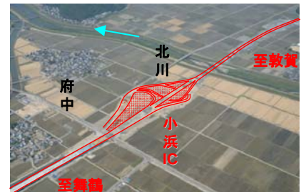
《舞鶴若狭自動車道 小浜IC付近 (提供:NEXCO中日本 H22.6撮影)》
