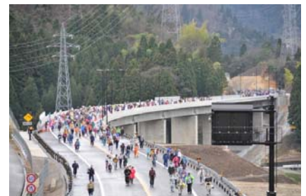
《中部縦貫自動車道 永平寺大野道路 開通記念イベント(H21.3.22) 中部縦貫道ハイウェイウォーク》
