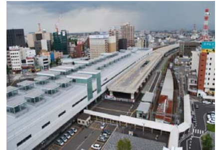
《北陸新幹線福井駅部高架橋》
