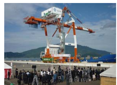
《鞠山南地区多目的国際ターミナルに 整備されたガントリークレーン》
