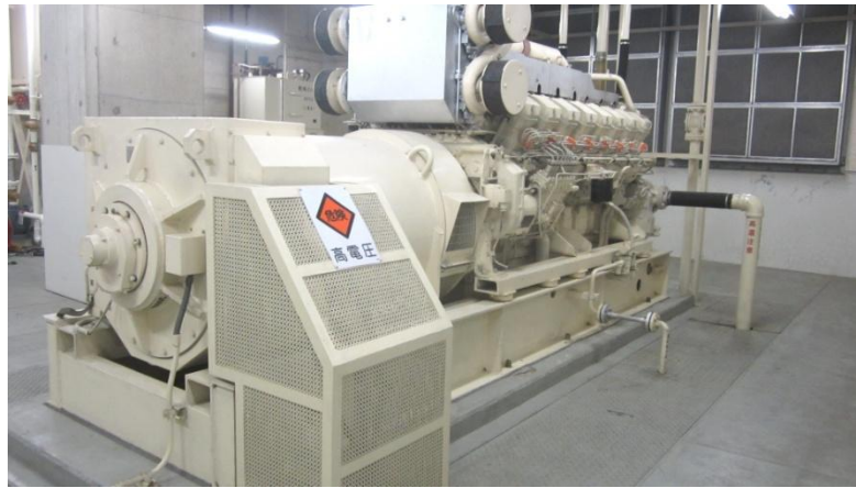
【 自家発電設備 】
