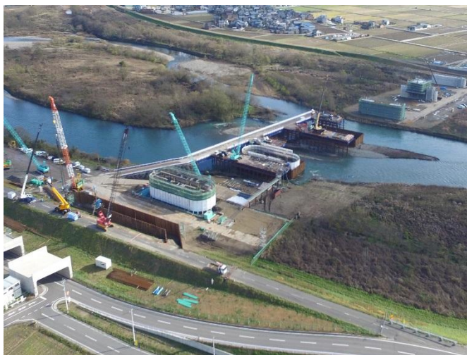
【九頭竜川橋りょう工事】
