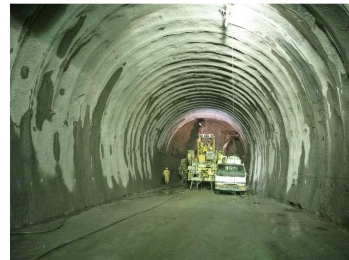
【新北陸トンネル工事(奥野々工区)】
