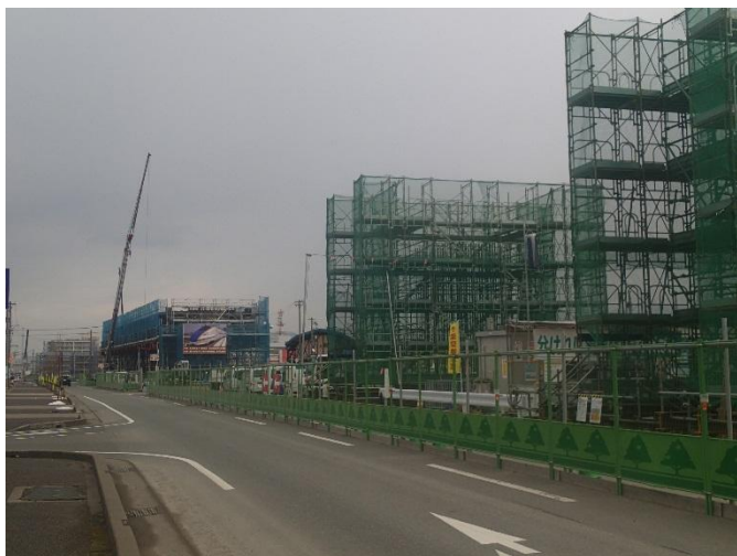
【福井高柳高架橋工事】
