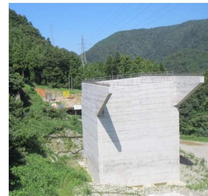
【荒島第1トンネル(仮称)付近 (大野市西勝原)】
