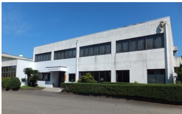
【ふくい林業研修センター(仮称)】 林業研修館を改修
