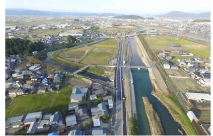
吉野瀬川放水路（H29.11 完成） （越前市）
