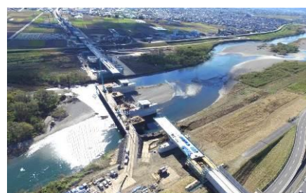
九頭竜川橋りょう (全国初の新幹線と道路の一体橋)
