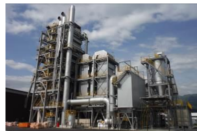
木質バイオマス発電施設 (H28.4 竣工) (大野市)
