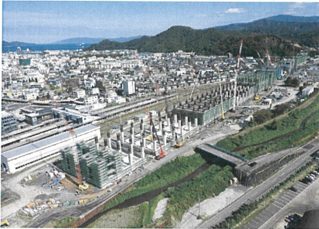
【敦賀駅高架橋】
