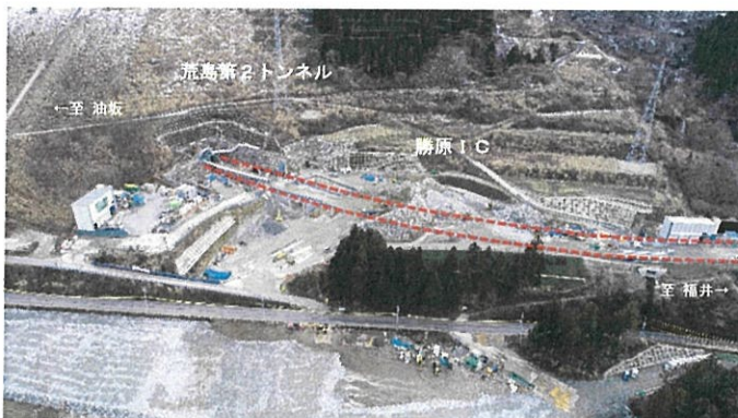
中部縦貫自動車道（大野油坂道路） 【荒島第2トンネル（仮称）付近（大野市西勝原）】
