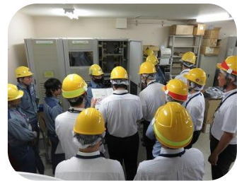
重要インフラ事業者への 立入検査
