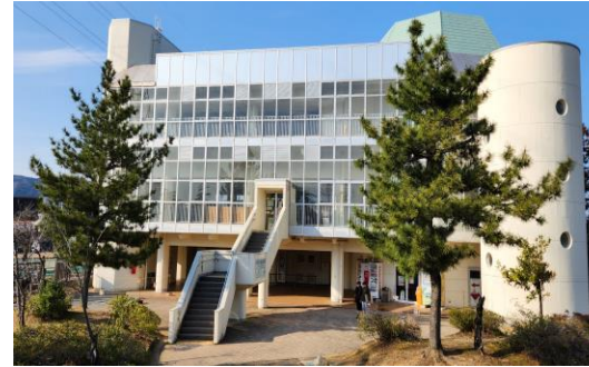
屋内休憩所(外観)
