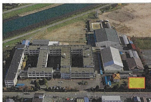
寮建設予定地
