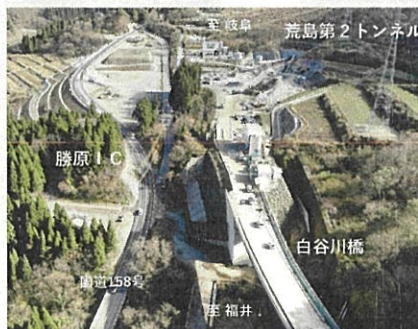
中部縦貫自動車道(大野油坂道路) 【勝原IC(仮称)(大野市西勝原)】
