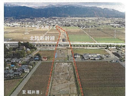
福井港丸岡インター連絡道路 【北陸新幹線交差点付近(坂井市丸岡町長崎)】
