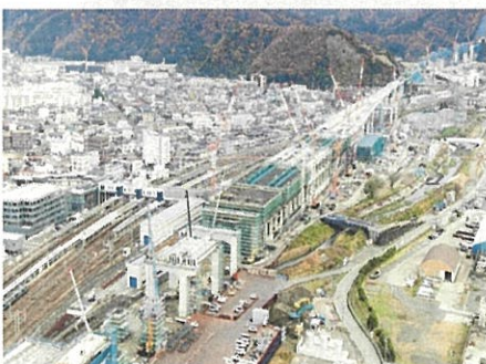
【敦賀駅高架橋】
