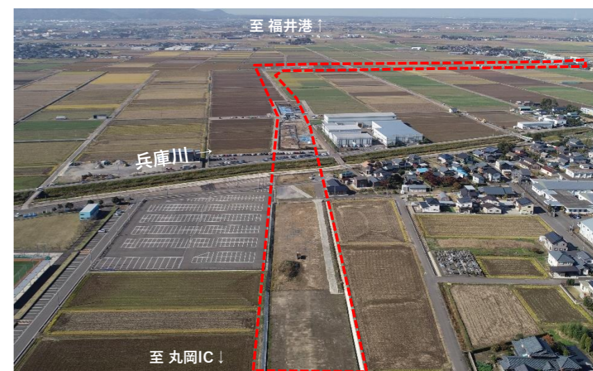
福井港丸岡インター連絡道路 【5号橋(仮称)架橋位置付近（坂井市丸岡町舟寄）】
