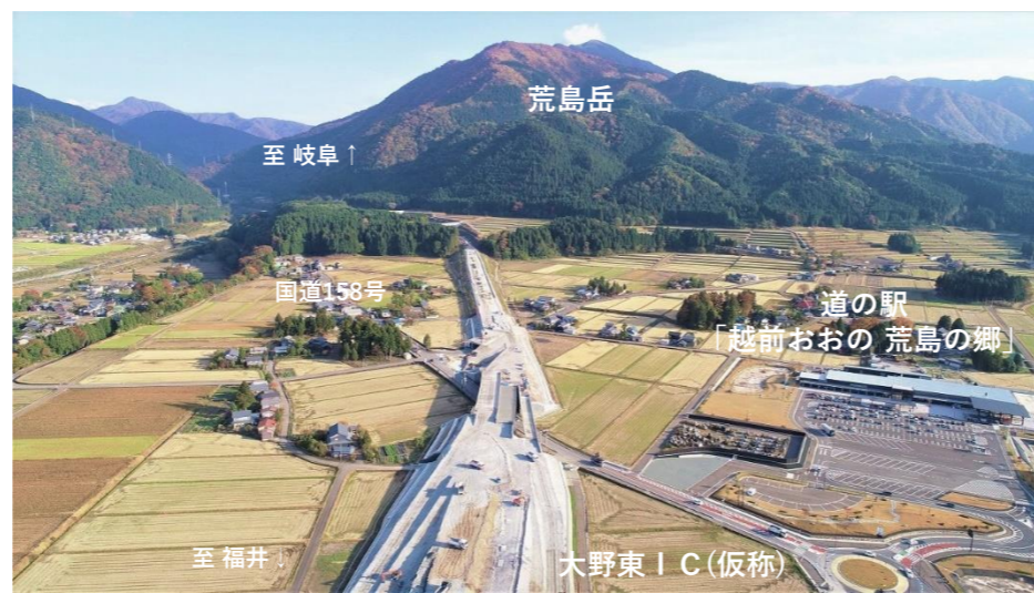
中部縦貫自動車道（大野油坂道路） 【大野東IC(仮称)付近（大野市蕨生）】
