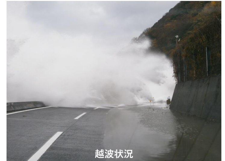
【越波対策（消波ブロック設置） ：国道305号 南越前町大谷】
