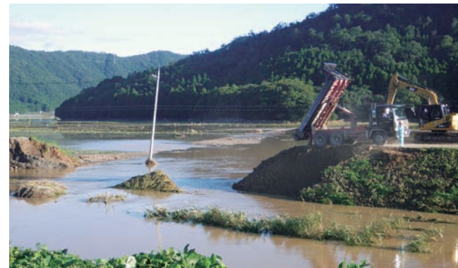
野木川の堤防が16日に破堤。18日の夕方に仮復旧完了(若狭町下野木)
