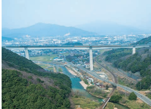
敦賀の町なみを眺望。敦賀衣掛大橋
