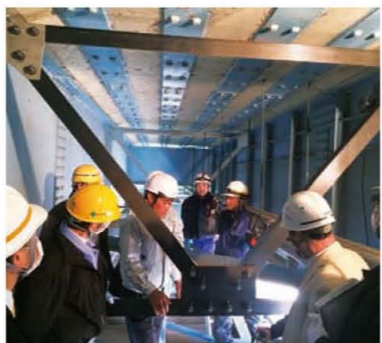
橋梁の補強部材の試験施工・実証試験を実施
