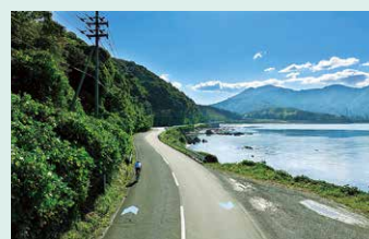
矢羽根が描かれた道路
