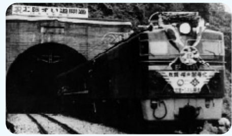
北陸トンネルの開通
