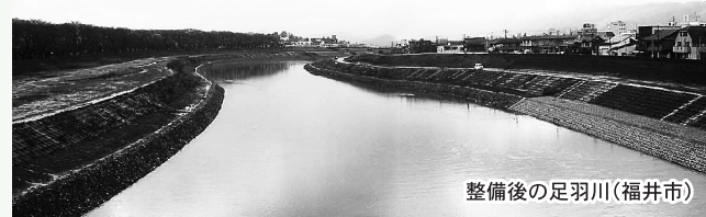
整備後の足羽川(福井市)
