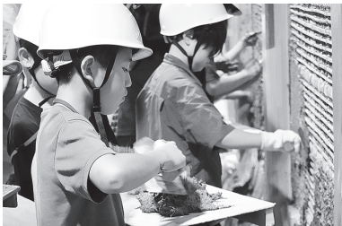
修理現場見学会で土壁塗り体験をする様子
