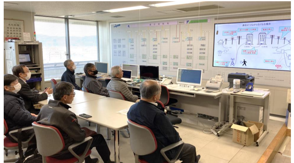
防災行政無線室
