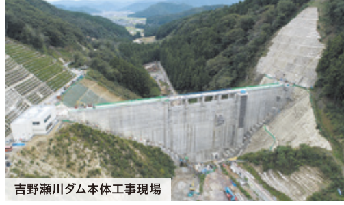
吉野瀬川ダム本体工事現場
