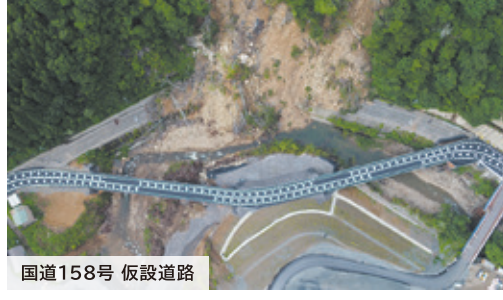
国道158号 仮設道路
