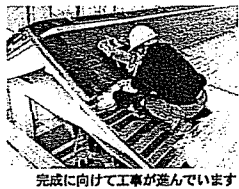
完成に向けて工事が進んでいます
