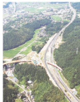
着々と工事が進む舞鶴若狭自動車道 (敦賀JCT付近)
