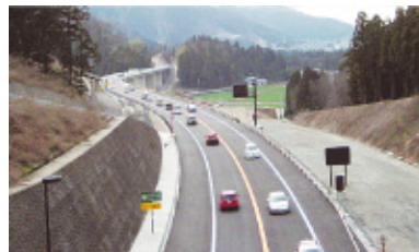
中部縦貫自動車道
