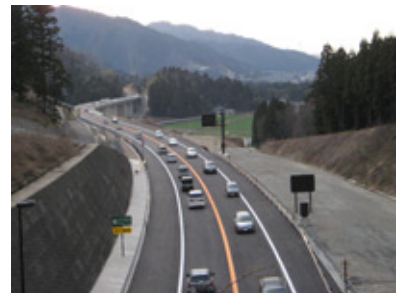
3月に開通した中部縦貫道の上志比―勝山間
