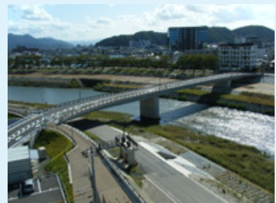
架け替え工事が終了した泉橋
