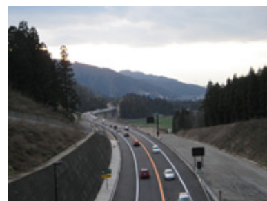
整備が進む中部縦貫自動車道
