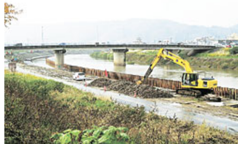
足羽川の河床掘削工事
