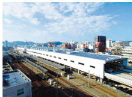
整備が進められているJR福井駅
