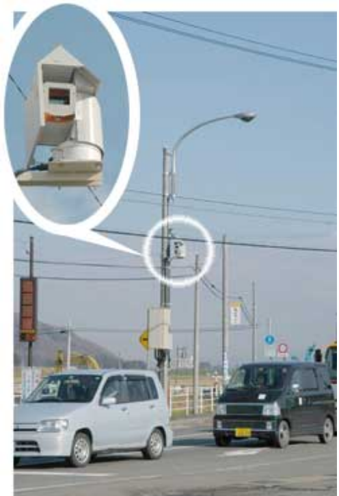
通学路など歩道除雪を推進します。路面監視カメラを増設し、迅速な情報提供に努めます…今年度増設した清水町竹生地点)
