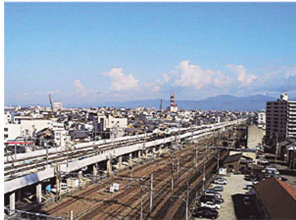
整備が進められるJR在来線福井駅 来年4月18日にはJR在来線の高架切替が予定されています
