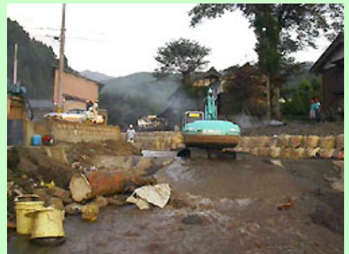
河川などの応急復旧工事を迅速に実施しました
