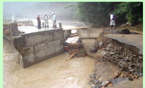
流出した橋梁(池田町)
