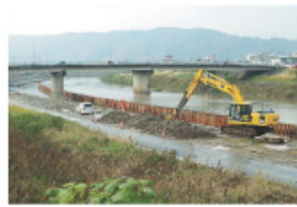
足羽川で進む河床掘削工事
