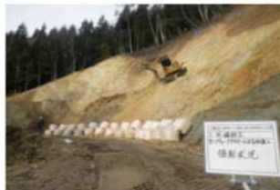
大型土壌による集水孔の養生
