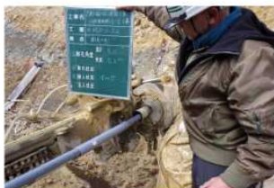
有孔管挿入状況
