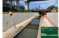
【自動追尾型TSを用いた出来形計測】
