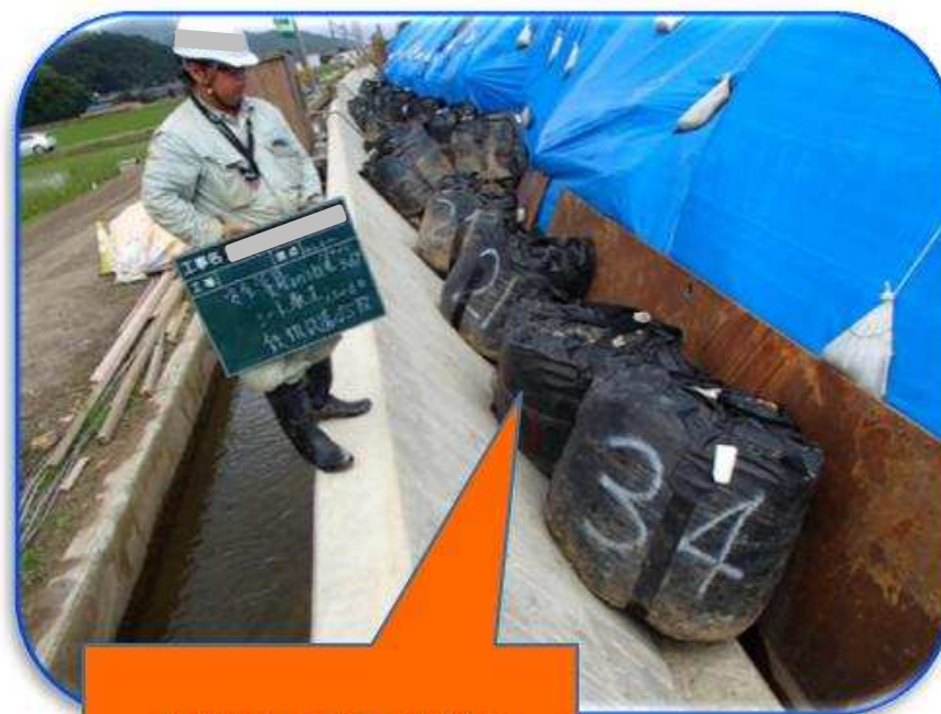
大型土のうで補強
