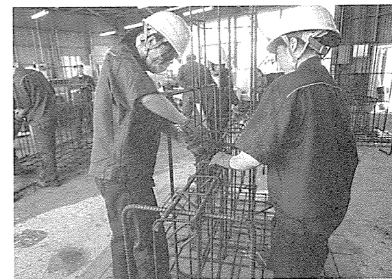
鉄筋施工実習
