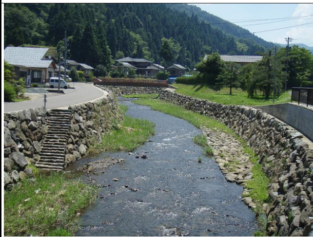
活用事例写真(活用部全景)
