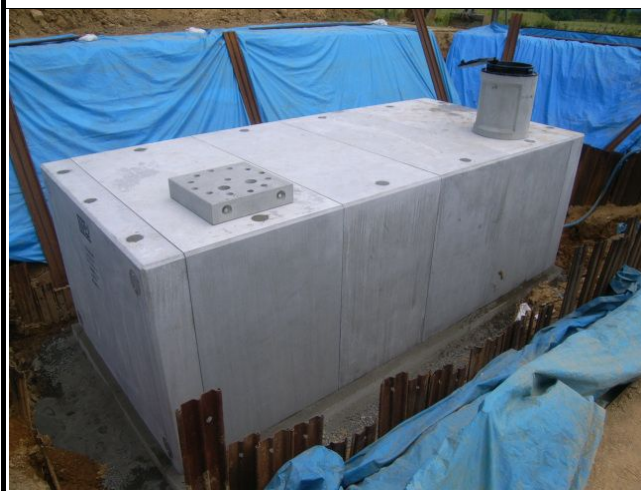
活用事例写真(活用部全景)
