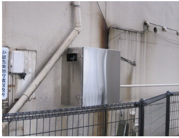
活用事例写真(活用部全景)
