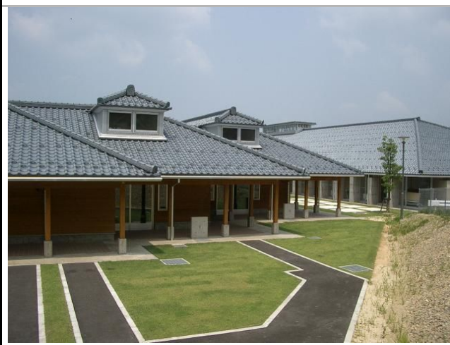
活用事例写真(活用部全景)
