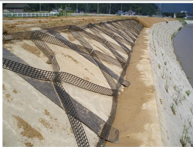
活用事例写真(活用部全景)
