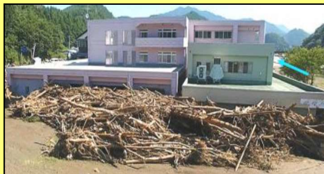
平成28年台風10号（岩手県岩泉町） ⇒ 洪水により高齢者福祉施設の利用者9名が死亡
