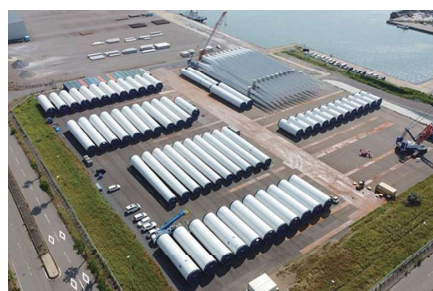
風力発電部材の仮置き
