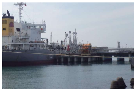
油槽船の係留施設(ドルフィン)
