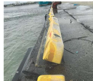
（岸壁の修繕＋車止め、係船柱の取替え）
