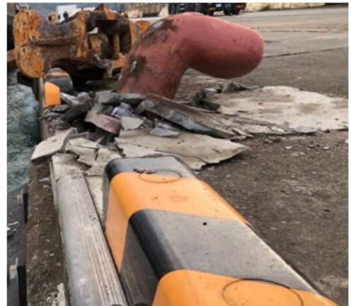
（岸壁の修繕＋車止め、係船柱の取替え）
