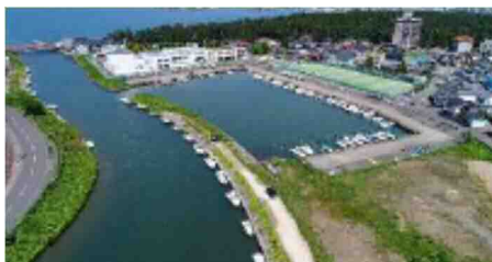
不法係留の状況（井の口川河口付近）
