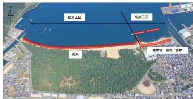
海岸侵食が発生している松原地区では養浜を実施
