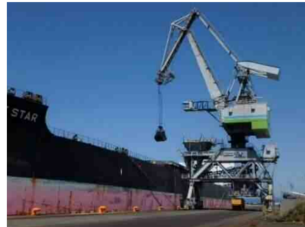
老朽化した多目的クレーンの状況
