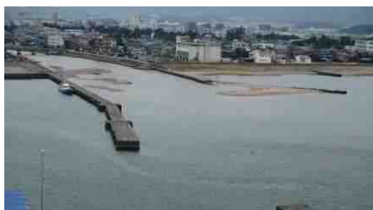
笹の川河口の土砂堆積状況
