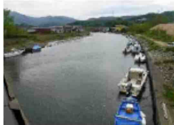
不法係留の状況（井の口川上流）
