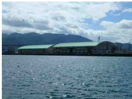
老朽化した倉庫の状況
