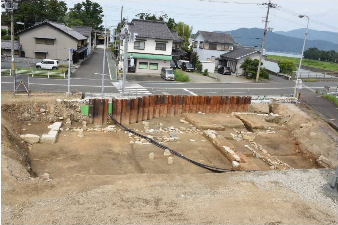
【I区:雲浜保育所跡地】第3遺構面検出状況(東より)
