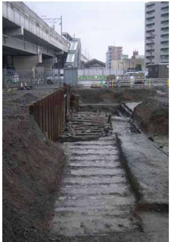
写真 4 3区調査状況（南から） （手前に枕木痕、奥に基礎）
