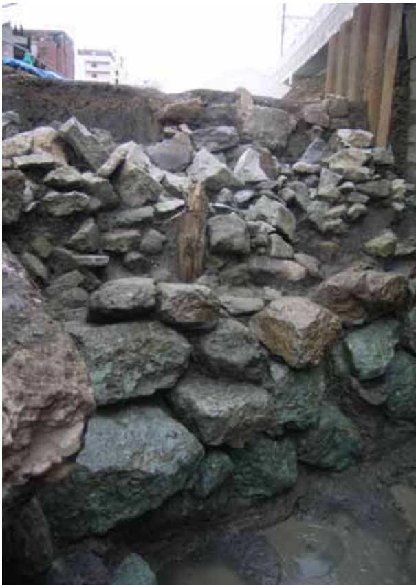
写真 3 2区百間堀石垣（北から）
