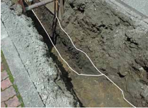
写真2 三ノ丸東側堀跡（東から）
